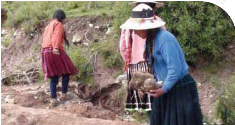
Caminos destruidos por lluvias en la comunidad de Wallia.
