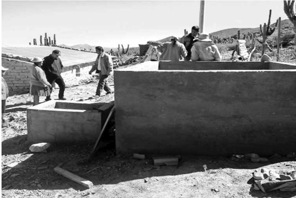
Tanque de distribución de agua a los sistemas de riego en los invernaderos.
