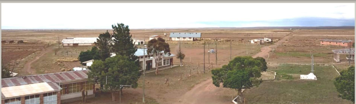
Foto: Vista parcial instalaciones de la Estación Experimental Patacamaya (Ing. Juvenal Choque Chura,2020)
