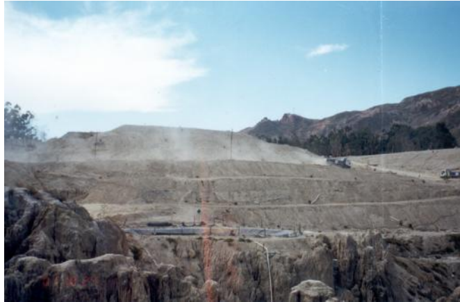
Figura 4. Relleno Sanitario de Mallasa en la ciudad de La Paz. Fuente: Foto CPTS (2001)
