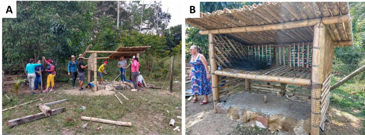
Figura 4: A) Proceso de construcción de galpón, B) Estructura de galpón y cerramientos con materiales residuales.
