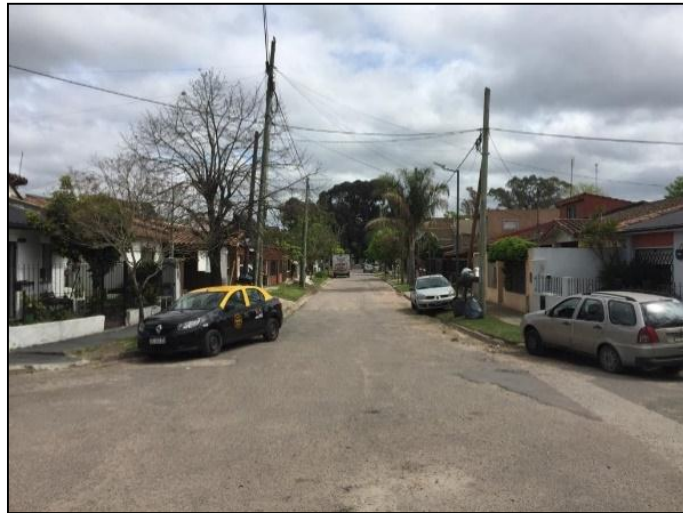
Figura N°3.- Vista de la calle Bruza, lado calle Pringles.
