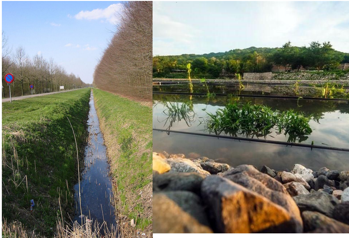
Figura 4. Zanjas de drenaje provistas de vegetación (izq.) y humedal artificial en Cihuatlán, Jal., México (der.)
