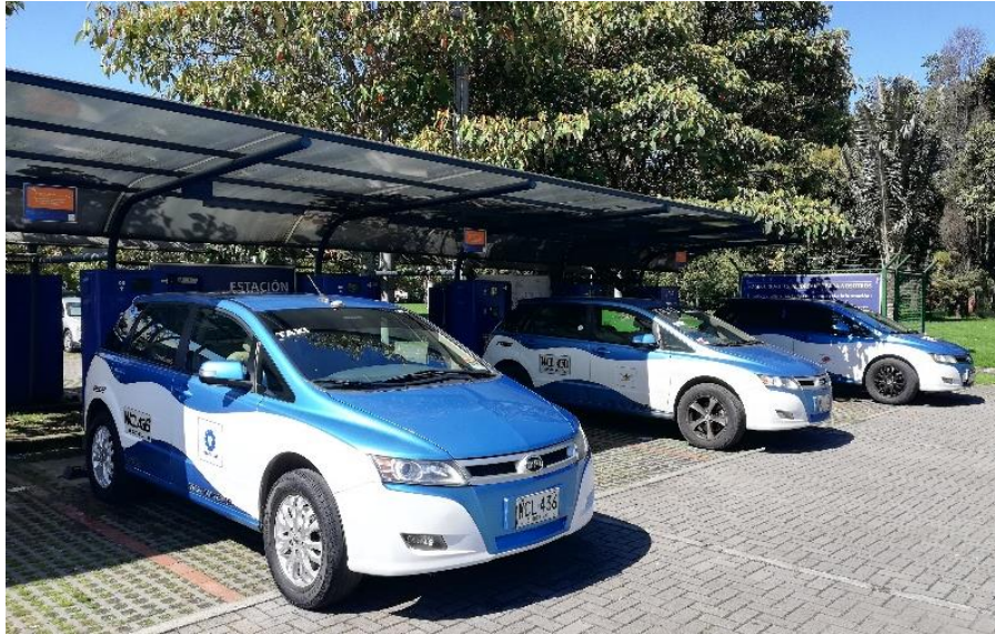
Figura 2. Estación de recarga para taxis eléctricos
