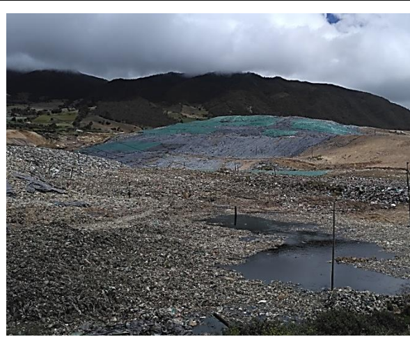
Patio de disposición de residuos en RSDJ, se puede observar la inadecuada captación de lixiviados. Fotografía de la Personería de Bogotá 2016.
