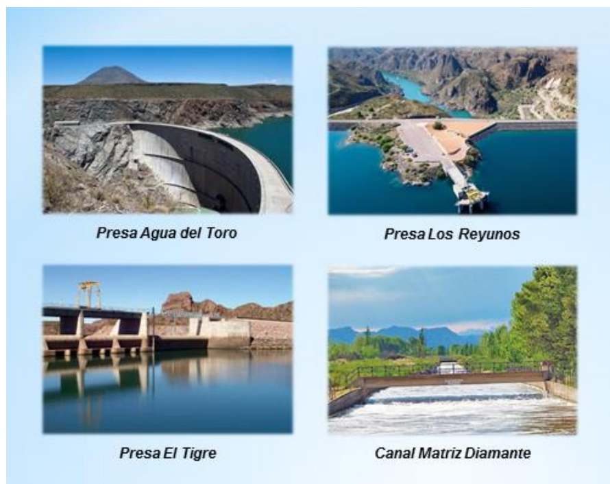
Figura 2: Imágenes de la infraestructura hidráulica de aprovechamiento del Río Diamante. Elaboración propia a partir de fotografías de la Secretaría de Recursos Hídricos de Argentina (2010).
