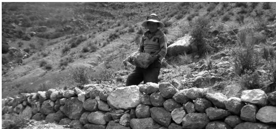
Construcción de terrazas de formación lenta como medida de conservación de suelos.
