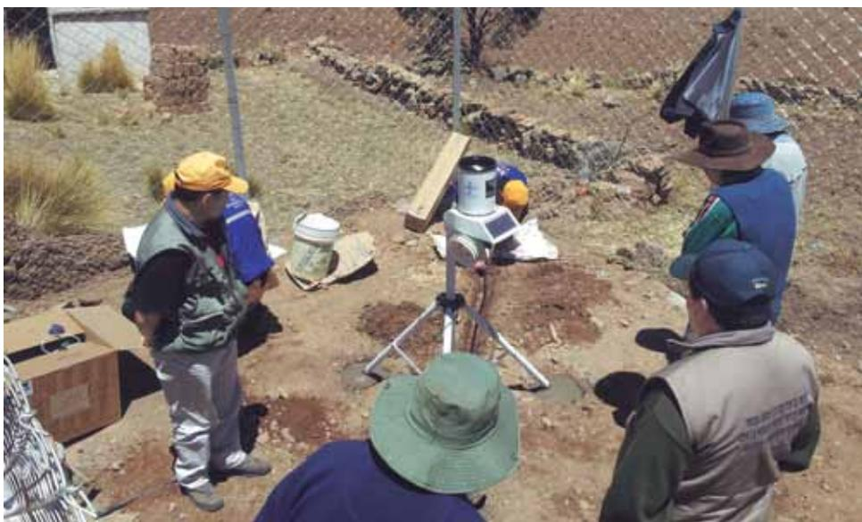
Instalación de una estación agrometeorológica telemétrica.
